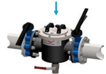
Entfernen Sie die schwarze Schraube am Deckel. Heben Sie die Magnetkerne mit dem Griff an der Oberseite der Einheit heraus. \*Siehe Warnung unten\*. Achten Sie darauf, dass Sie die Kerne nicht an oder in der Nähe von eisenhaltigen Objekten positionieren.
